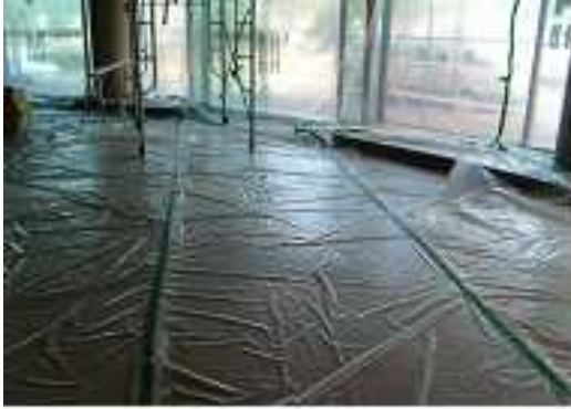
그림 49. 바닥비닐 설치
