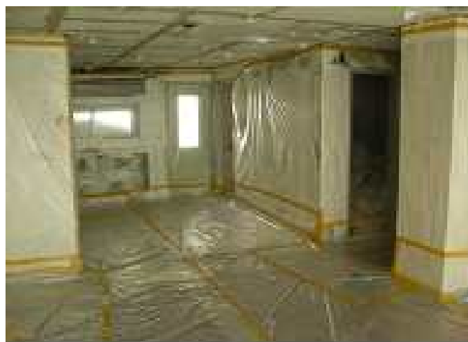
그림 32. 비닐시트를 이용한 밀폐
